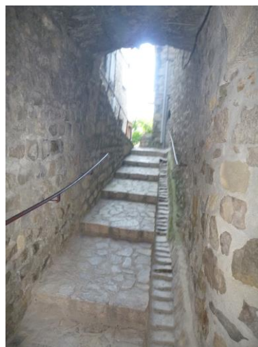
Figure 17 : Evacuation des eaux pluviales par ruissellement sur la chaussée
