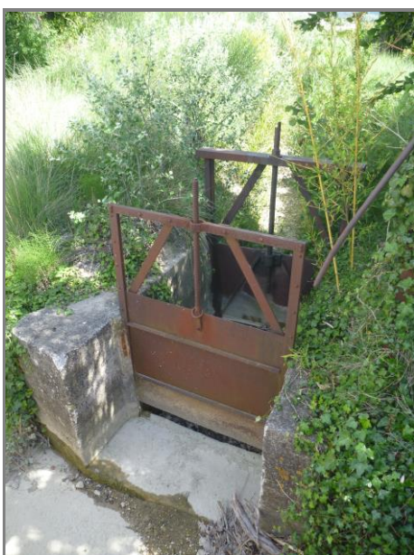
Figure 26 : Exemple de vanne pelle observée lors des investigations de terrain
